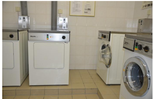
Waschraum mit Waschmaschinen und Trocknern
